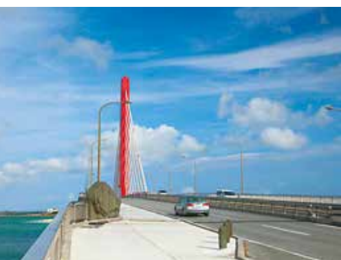
海中道路に続く平安座海中大橋。
